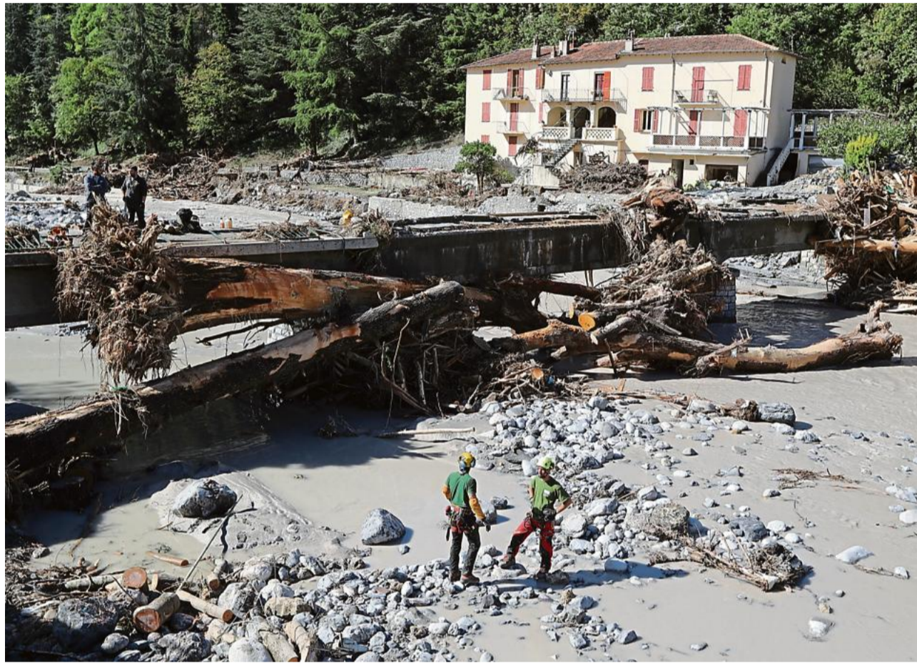
Les crues dans les Alpes-Maritimes ont provoqué de très importants dégâts sur les infrastructures. Photo Valéry Hache/AFP
